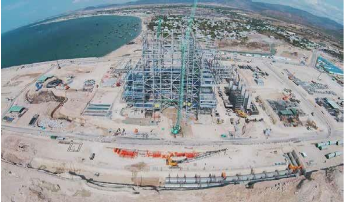
Toàn cảnh Vinh Tân 4, khu vực Nhà máy chính đang thi công, TV2 là thành viên của Tổ hợp nhà thầu EPC
