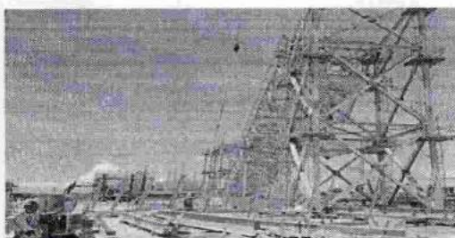
Kết cấu thép cho hệ thống CHS cho nhà máy nhiệt điện
