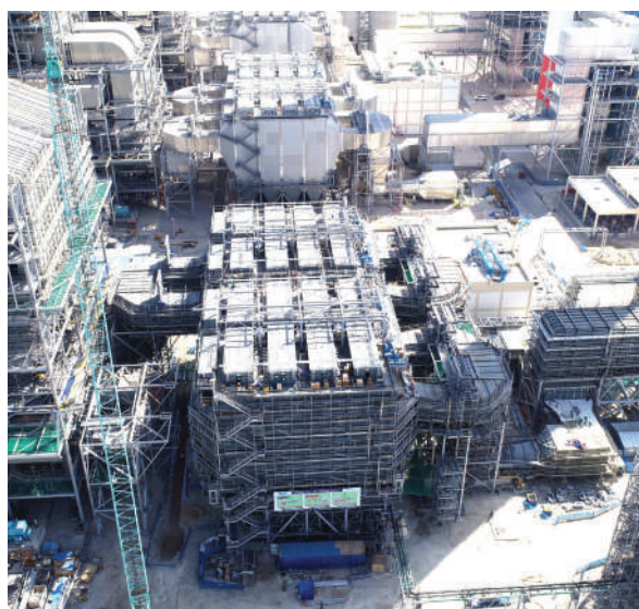
Công trường NM Nhiệt điện Vinh Tân 4 Mở rộng
