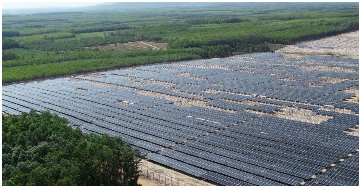
NM Điện mặt trời Sơn Mỹ 3.1 đang thi công
