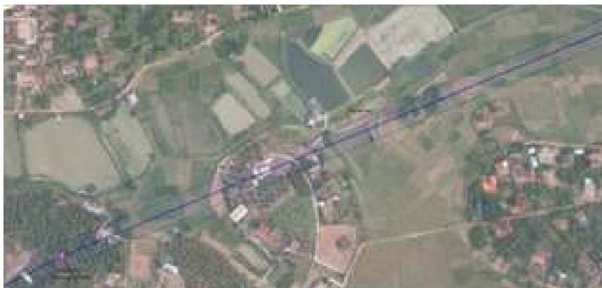
Khảo sát không ảnh đường dây 220kV
